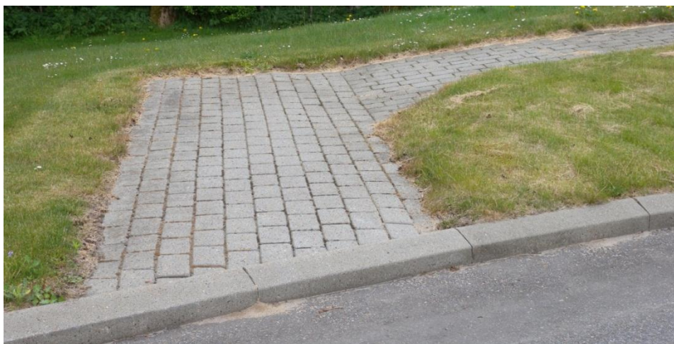
Belægning af betonsten/Fliser
