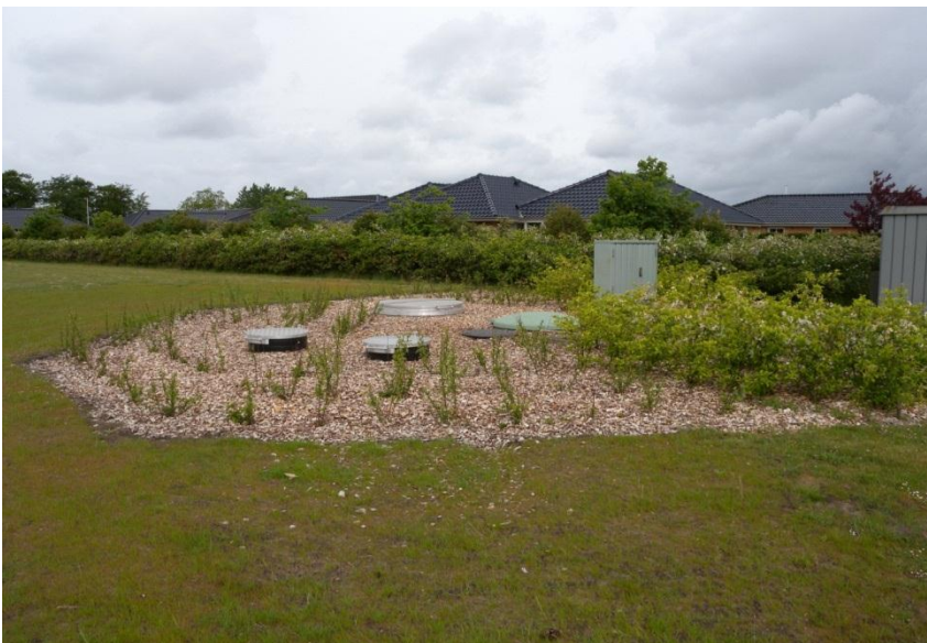
Ny anlagt bed ved pumpestation Skovtoften Skjern.
